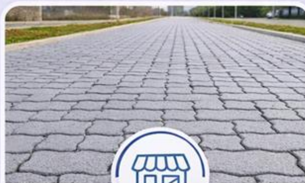
Pavimentação Intertravada de Concreto
