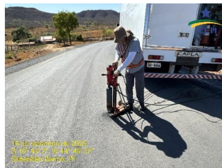
Figura 13: Execução de extração
