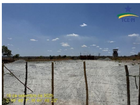
Figura 24: Local onde foi locada a Usina
