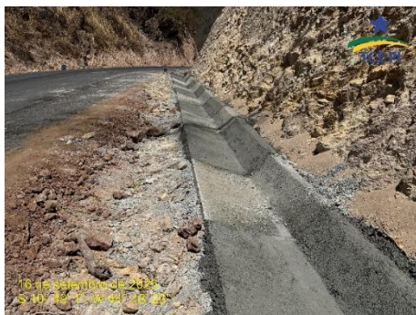
Figura 18: Sarjeta em execução
