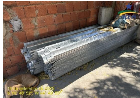
Figura 21: Defensas metálicas a serem instaladas
