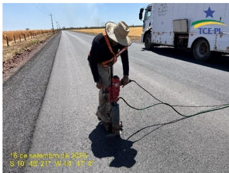
Figura 16: Execução de extração
