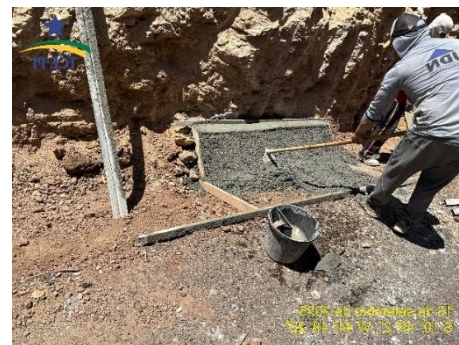
Figura 19: Sarjeta em execução
