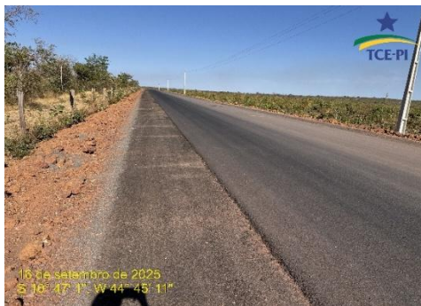
Figura 10: Visão geral do rodovia
