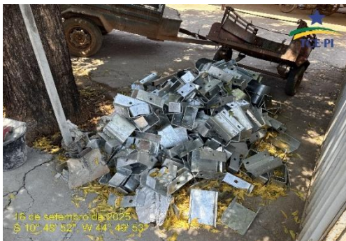
Figura 22: Defensas metálicas a serem instaladas
