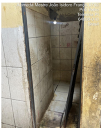
Figura 11 - Banheiro na Casa de Acolhimento Ka-Ubanoku Piratinga
