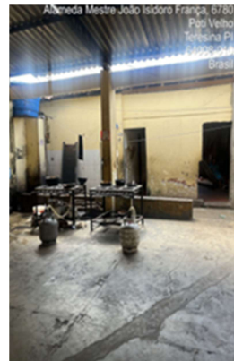
Figura 31 - Botijões de gás em local inapropriado (2)
