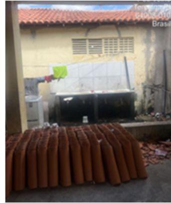
Figura 22 - Entulho acumulado Casa de Acolhimen- to Ka-Ubanoko Piratinga (2)
