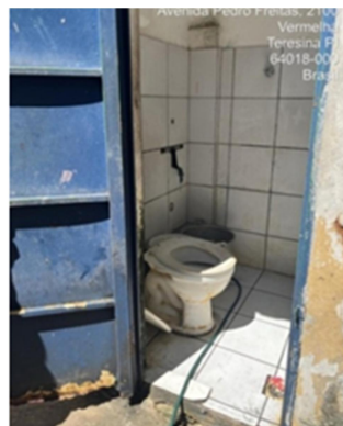
Figura 8 - Banheiro na Casa de Acolhimento Ka-Ubanoko- São João
