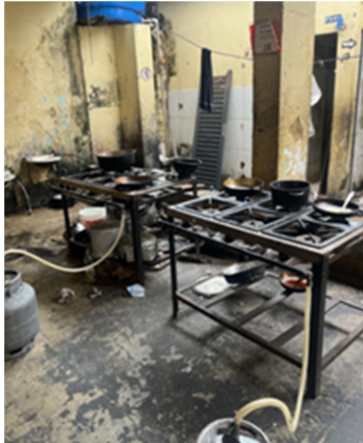
Figura 17 - Botijões de gás Casa de Acolhimento Ka-Ubanoko – Piratinga
