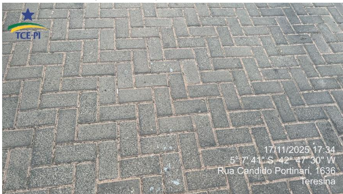
Figura 12 – Pavimentação com Intertravado de Concreto.
