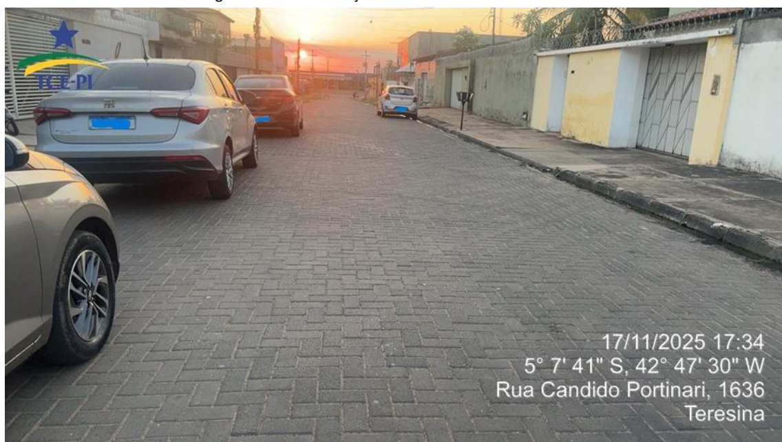
Figura 11 – Pavimentação com Intertravado de Concreto.
