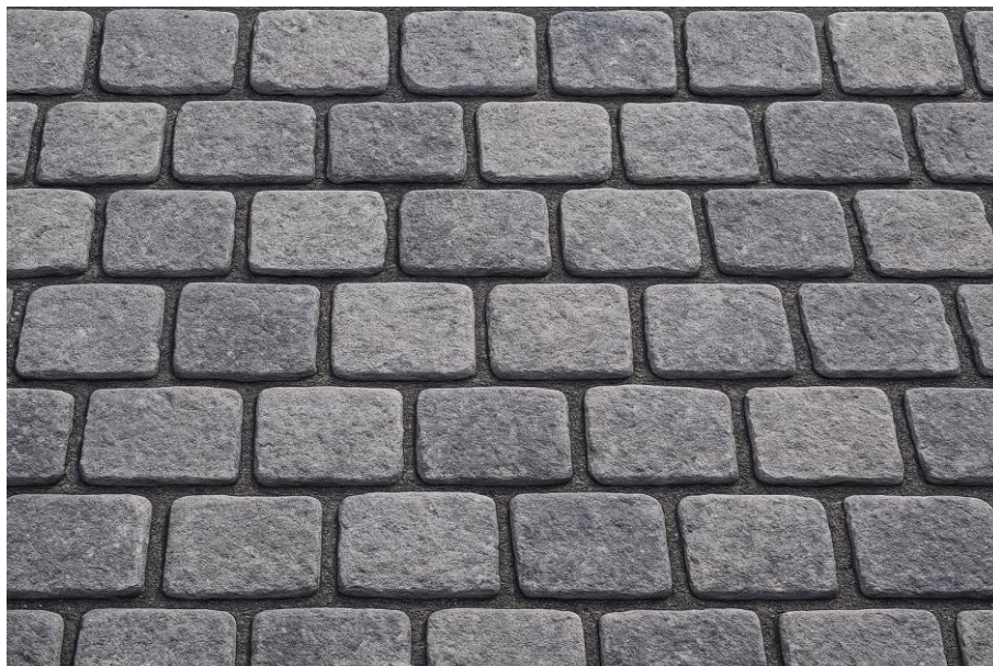
Figura 7 – Ilustração da Pavimentação em Paralelepípedo.
