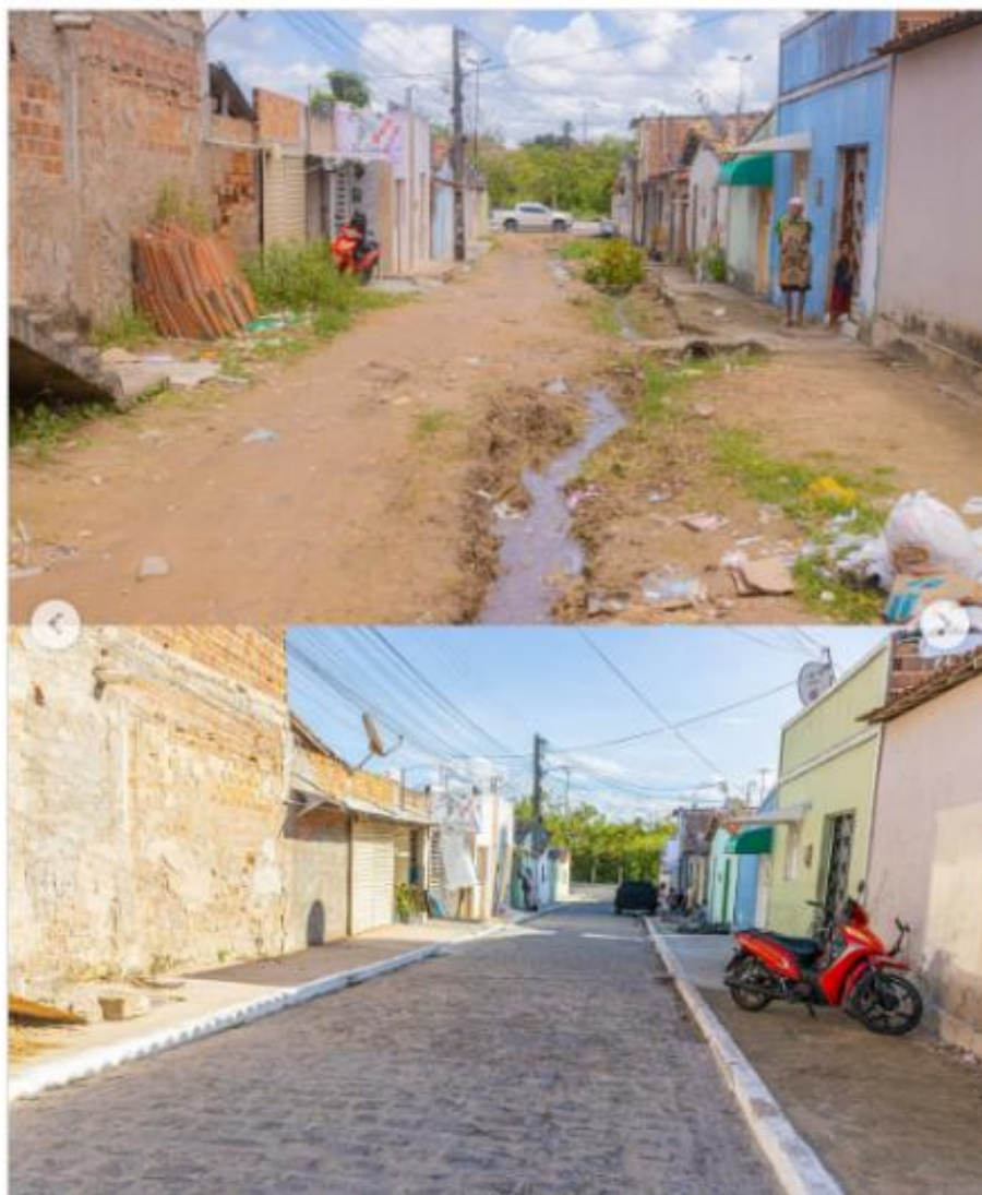
Figura 5 – Antes e depois de obra de pavimentação.
