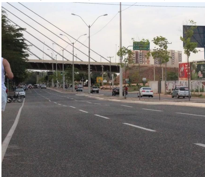
Figura 15 – Pavimentação Asfáltica na Avenida Raul Lopes.
