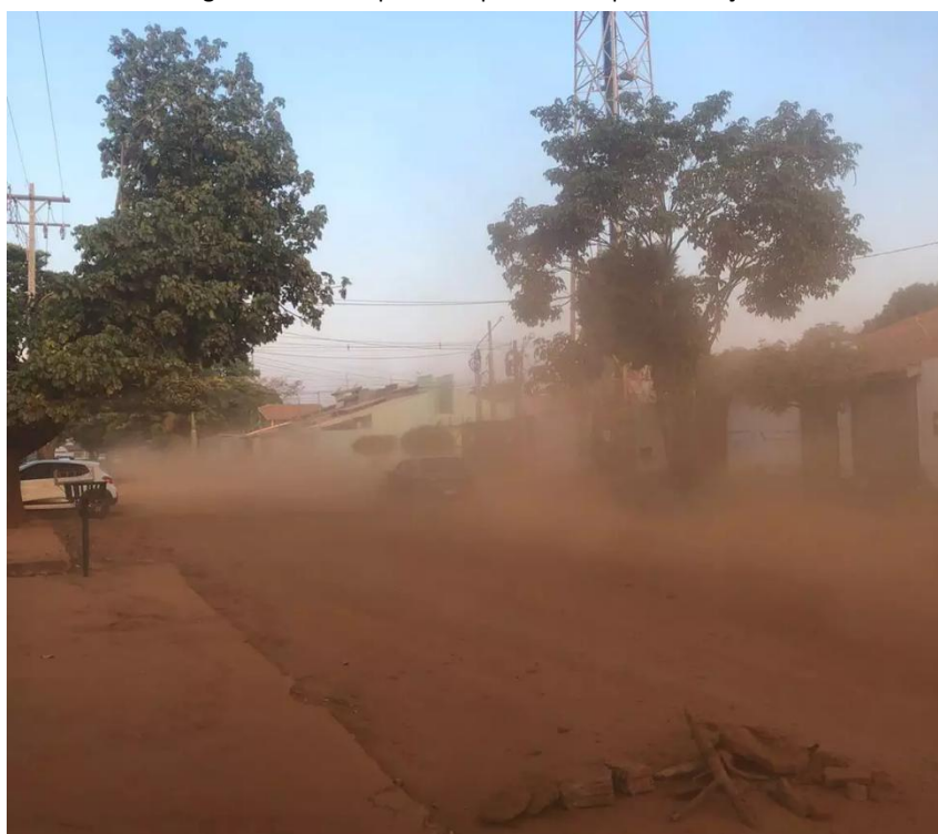
Figura 2 – Rua empoeirada por falta de pavimentação.
