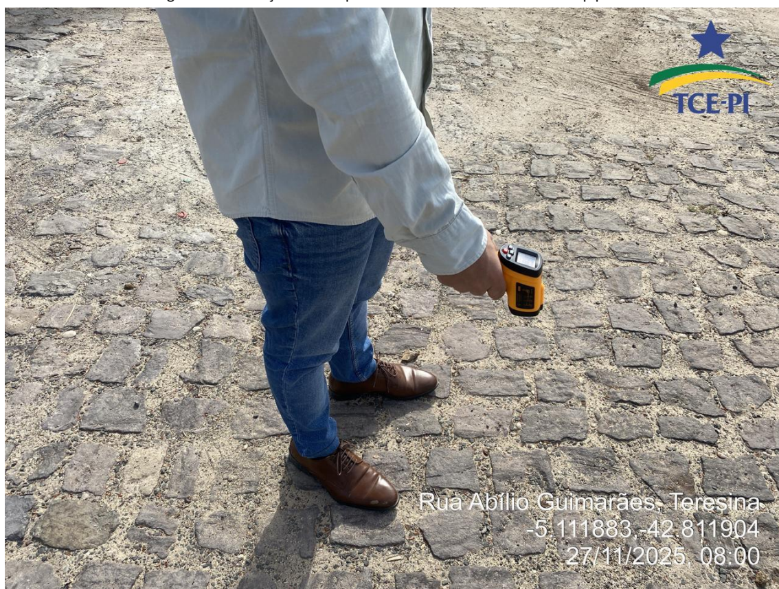
Figura 33 – Medição de Temperatura em Pavimento de Paralelepípedo.
