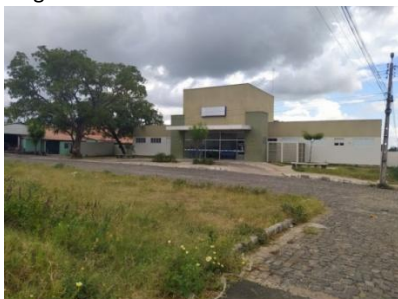
Figura 9 – Prédio da UBS José Cândido
