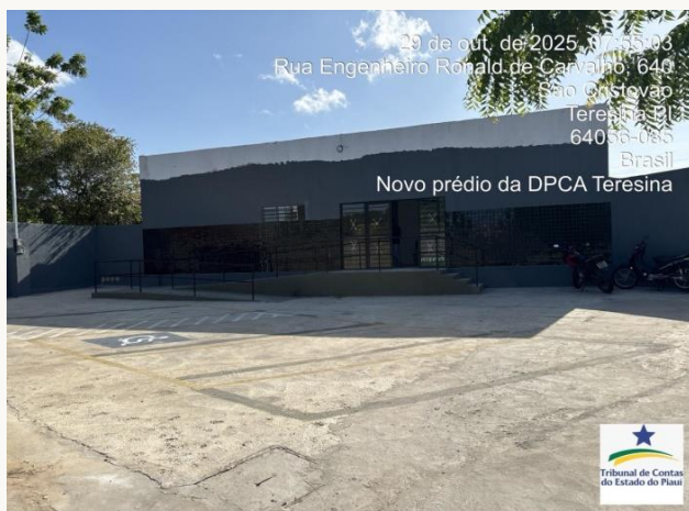
Figura 19 Fachada frontal da nova DPCA em visita no dia 29/10/2025, em finalização de pintura.
