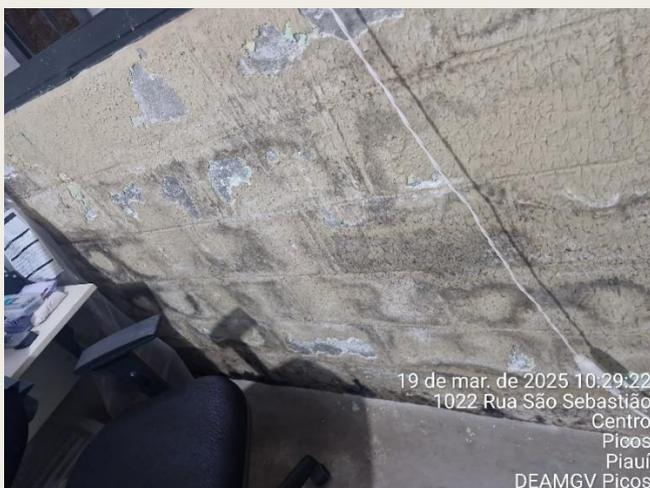
**Figura 17** Parede da sala de cartório da DEAMGV em Picos com infiltração e mofo.
