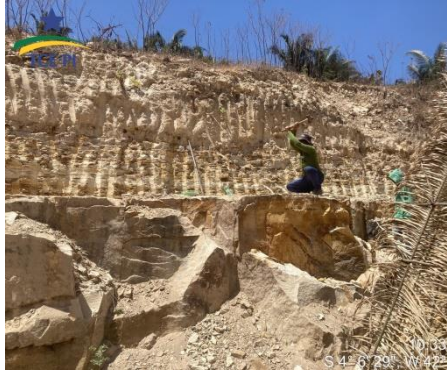
Figura 26- Cravação dos "pichotes", para realizar o tombamento do matacão.
