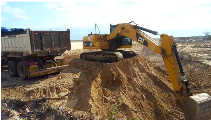
Figura 25 – “Decapeamento” do solo, com uso de maquinário.
