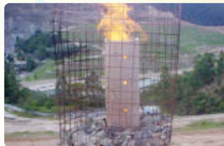
Coroamento de drenos verticais com queimadores
