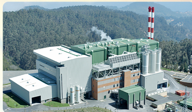
Unidade de incineração de resíduos sólidos da ETRS da Meia Serra, Ilha da Madeira-Portugal
