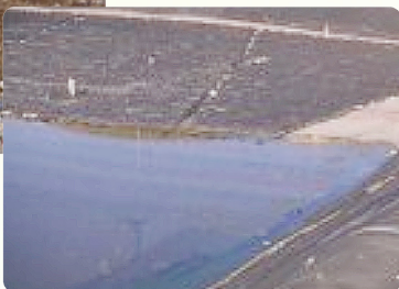
Impermeabilização de base das células de concentração de resíduos sólidos com manta PEAD - Fonte: ERSUC (2008)
