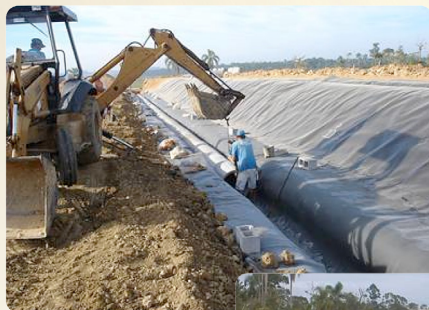
Construção de dreno principal de chorume.
