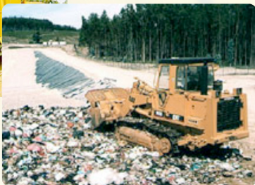
Recobrimento de resíduos sólidos com material inerte - Fonte: ERSUC (2008)
