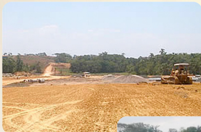
Terraplenagem da base de células de contenção de resíduos sólidos Fonte: SANTEC (2008)
