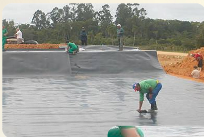
Colocação de manta PEAD
