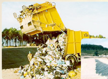
Espalhamento e compactação de resíduos sólidos na célula de contenção - Fonte: ERSUC (2008)
