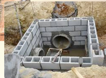
Caixa de inspeção de rede de drenagem de águas superficiais
