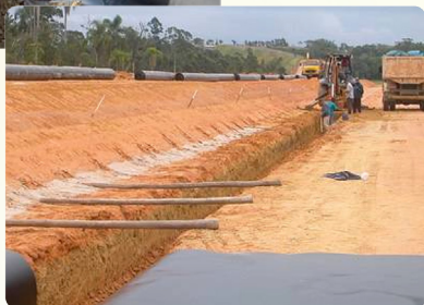
Construção e conexão da rede secundária com o dreno principal de chorume.
