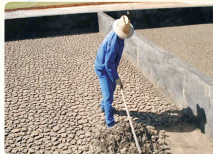
Leito de secagem de efluente do tratamento de chorume
