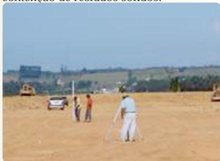
Acompanhamento topográfico da construção da célula de resíduos sólidos.
