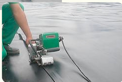
Termosoldagem de manta de PEAD
