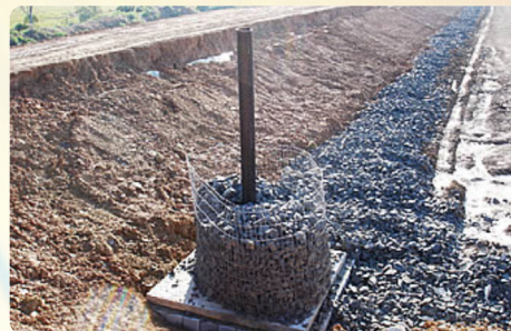
Drenos verticais em construção concomitante
