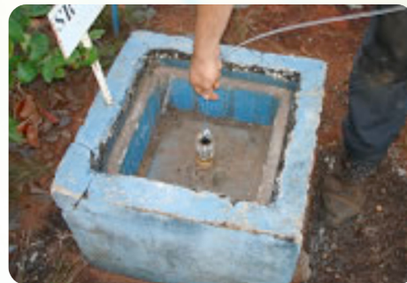
Vista superior de caixa de inspeção de poço piezométrico
