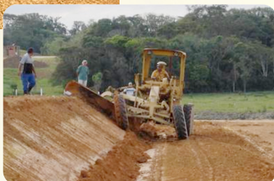
Conformação de talude de célula de contenção de resíduos sólidos Fonte: SANTEC (2008)
